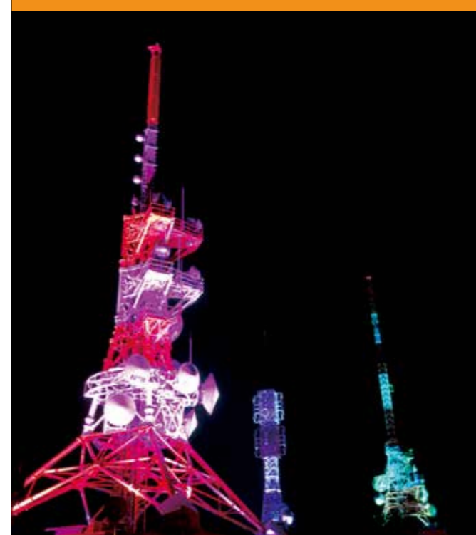
電塔ライトアップ・・・遠隔地からスケジュール設定、マニュアル操作
